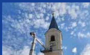
Kirchenrenovierung Markus Walgenbach Seite 21
