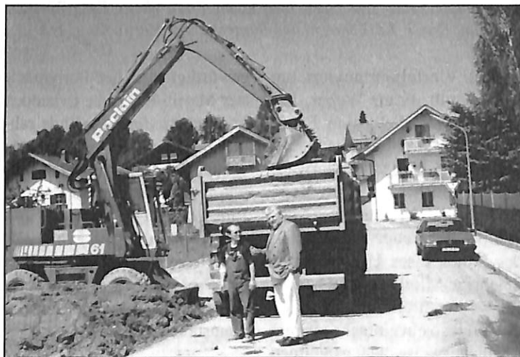
Andreas Skorte von der Grasbrunner Baufirma informierte Bürgermeister Martin Esterl (v.l.) über den Fortgang der Parkplatz-Anlage an der Schulstraße. Foto: K. Kilger
